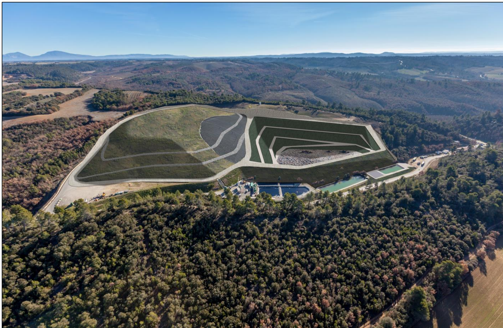
Figure 6 : Projet paysager d'aménagement du second casier et de couverture du premier casier
